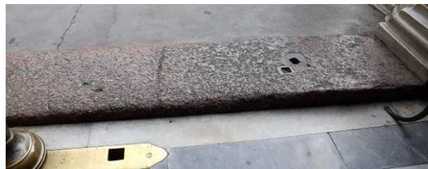
*La Porta dei Canonici risulta accessibile tramite rampa, in cemento, dotata di corrimano ad entrambi i lati, lunga 510 cm, con pendenza c.a. 9/10% e soglia, in granito, al varco d'ingresso, larga 42 cm e con scalino interno con altezza variabile 5/6 cm ed esterno con altezza variabile 4,5/5,5 cm. L'interno è percorribile anche dai visitatori in sedia a ruote.*
